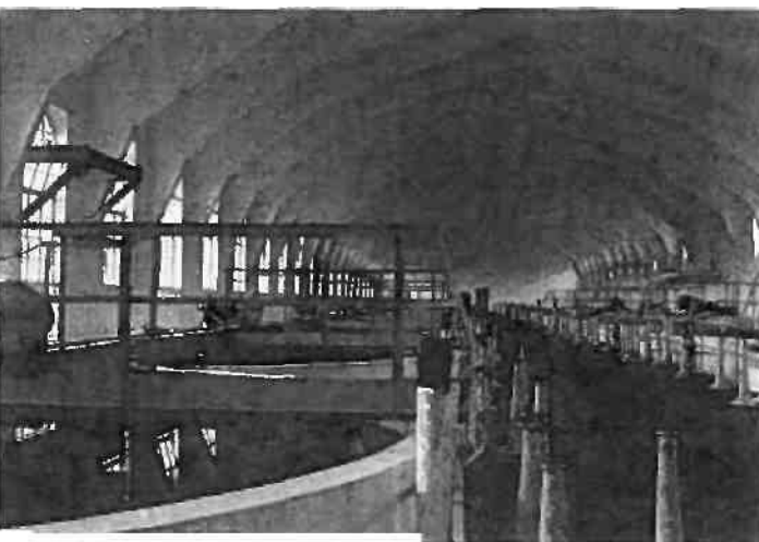
Acquedotto Randaccio : impianti di filtrazione
