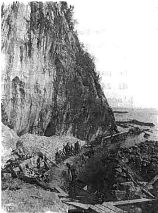
Anno 1900. Costruzione dei serbatoi di raccolta delle sorgenti di Aurisina
