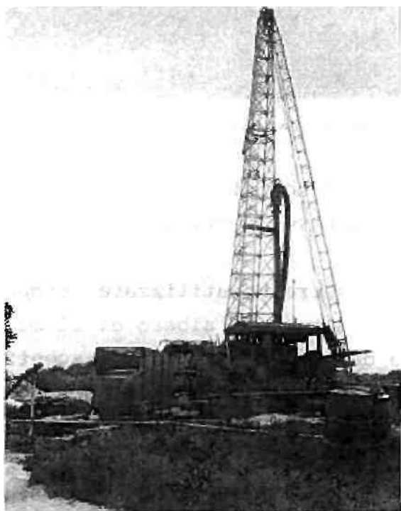
Perforazione del pozzo di Cassegliano
